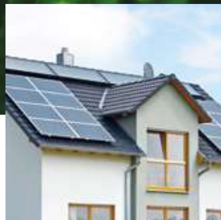
MODUŁY I INWERTERY FOTOWOLTAICZNE
